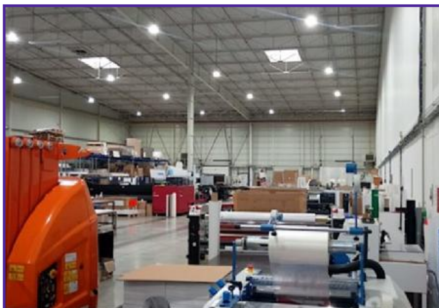
Obr. 2 Výrobní hala tiskárny Akcent s LED osvětlením a automatickým řízením jasu
